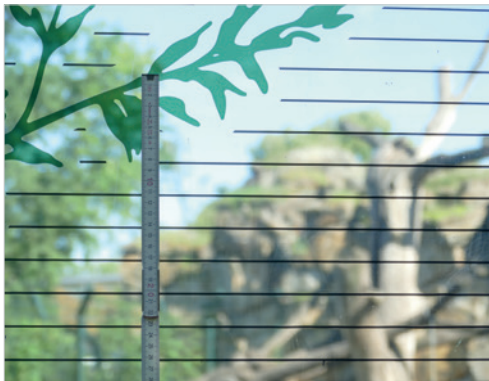
■ Abbildung 7: Detail der wirksamen Schutzfolie aus Abb. 6, die Streifen sind 2 mm breit und haben einen Kantenabstand von 28 mm. – Detail of the effective lamination of fig. 6, black lines are 2 mm wide and have a space of 28 mm. Foto: K. Steiof
