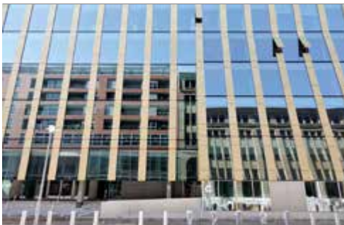
Berlin, Bürogebäude. – Office building.
