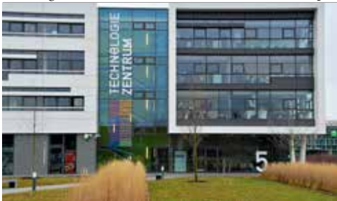
Augsburg, Gewerbegebäude. – Industrial unit. Foto: B.-U. Rudolph
