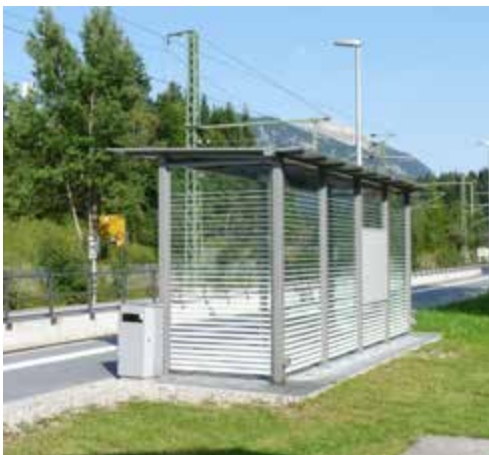
■ Abbildung 3: Fahrgastunterstand der Deutschen Bahn mit charakteristischer Streifenmarkierung. – Passenger shelter of Deutsche Bahn marked with stripes against bird collisions.
