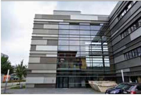
Berlin, Bürogebäude. – Office building.
