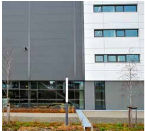
■ Abbildung 20: Die Fassaden sollten zur Bewertung in homogene Abschnitte unterteilt werden. – For assessing the collision risk, it helps to divide building fronts in homogenous parts. Foto: B.-U. Rudolph
