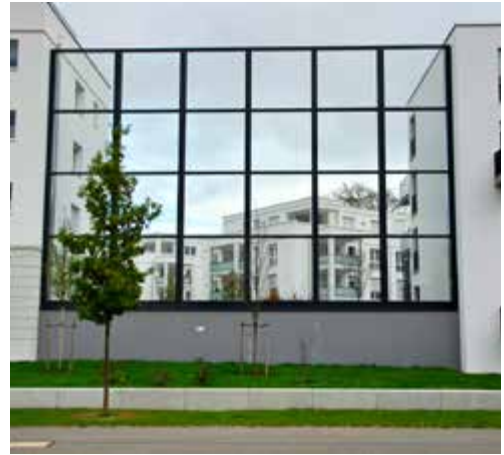
■ Abbildung 12: Hohe transparente Trenn- und Lärmschutzwand an einem Gebäudekomplex. Vogelschlag ist hier wiederholt nachgewiesen. – A tall transparent noise protection wall between buildings. Bird strikes have been recorded at this building. Foto: B.-U. Rudolph
