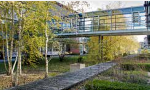
Augsburg, Verwaltungsgebäude, Übergang. – Passage at office building. Foto: B.-U. Rudolph
